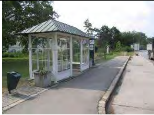
Abbildung 58: Bushaltestellenhäuschen in Laxenburg (Quelle: eigenes Foto)
